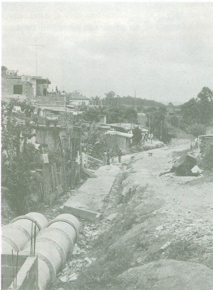
Favela Icarai Córrego já canalizado durante as obras de urbanização em mutirão
