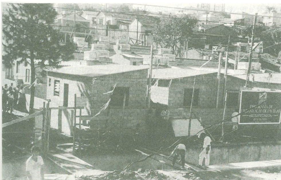
Favela São Domingos Obras de Urbanização - Gestão Luiza Erundina
